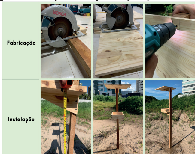
Figura 11 - Fabricação e Instalação de Suporte para Vela Úmida.
